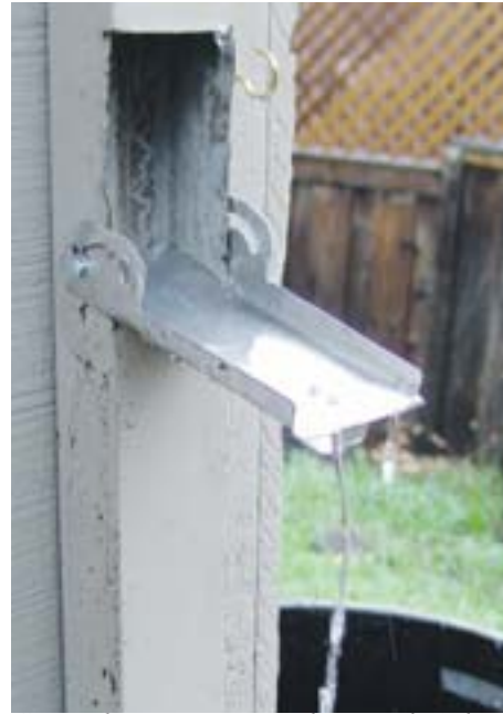
Gutter door Photo Andy Scheck
